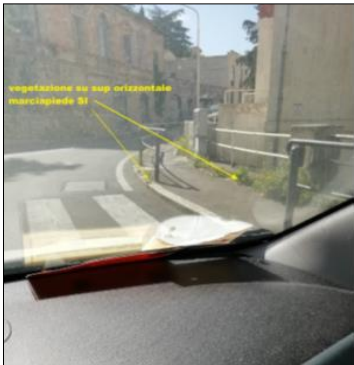
Vegetazione su superficie orizzontale marciapiede
