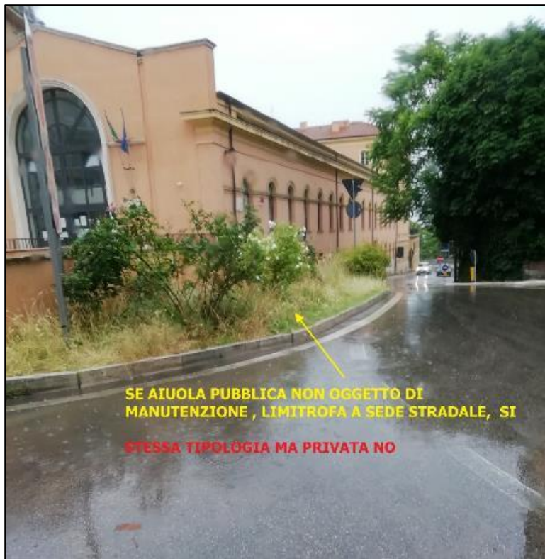
Aiuola pubblica non oggetto di manutenzione e limitrofa a sede stradale
