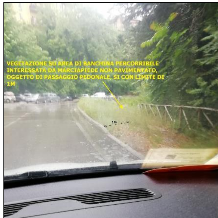
Vegetazione su area di banchina percorribile interessata da marciapiede non pavimentato oggetto di passaggio pedonale, limite 1 Metro
