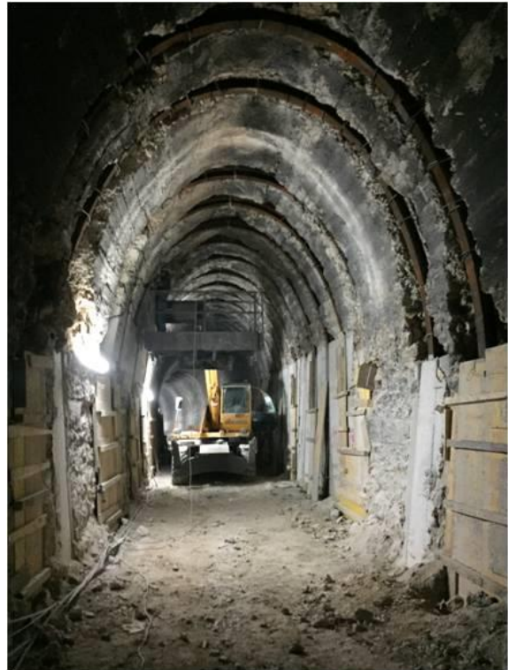
Figura 9 Fasi della lavorazione - inserimento centine
