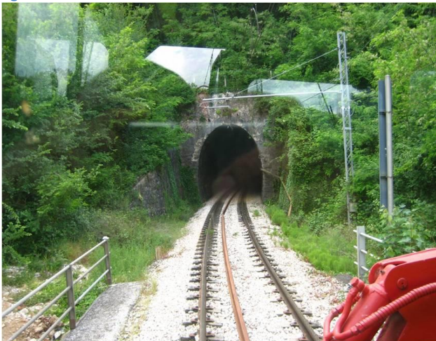
Figura 12 Portale di ingresso lato Perugia - stato prima intervento
