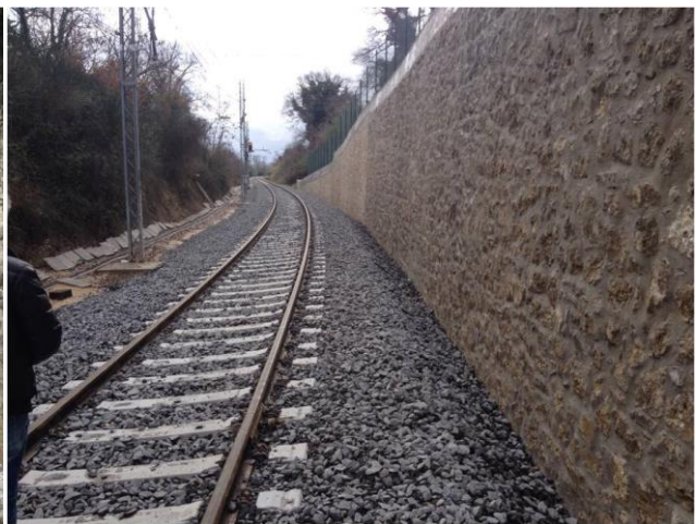
Figura 15 Muro al km 95+350 - stato dopo intervento
