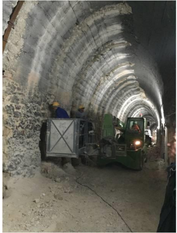
Figura 7 Fasi della lavorazione - inserimento centine
