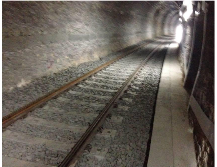
Figura 11 Interno galleria dopo intervento
