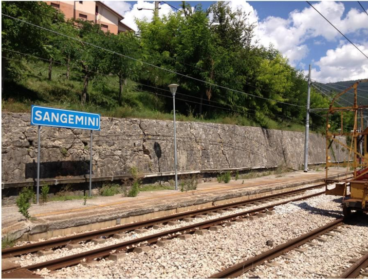
Figura 16 Muro di stazione - stato prima lavori
