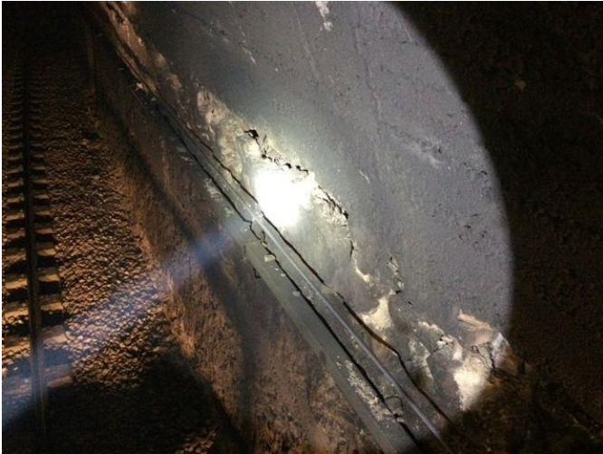
Figura 3 piedritto lato destro
