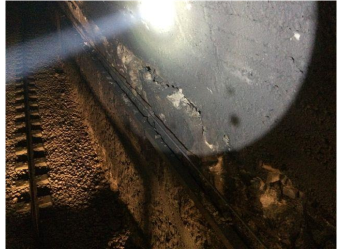
Figura 4 piedritto lato destro
