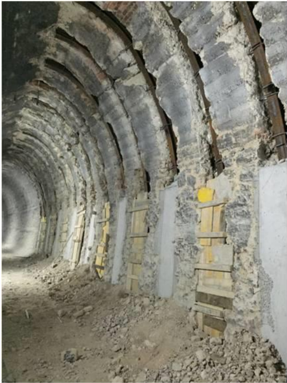
Figura 10 Fasi della lavorazione - inserimento centine
