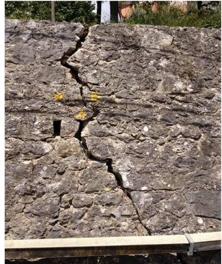
Figura 17 Muro di stazione - dettaglio del dissesto
