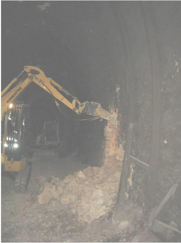
Figura 6 Fasi della lavorazione - demolizione piedritti
