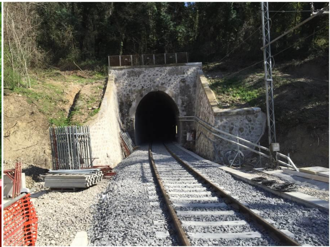
Figura 13 Portale di ingresso lato Perugia - stato dopo intervento
