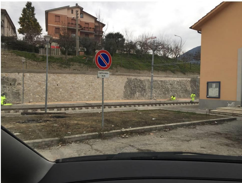
Figura 18 Muro di stazione - dopo i lavori
