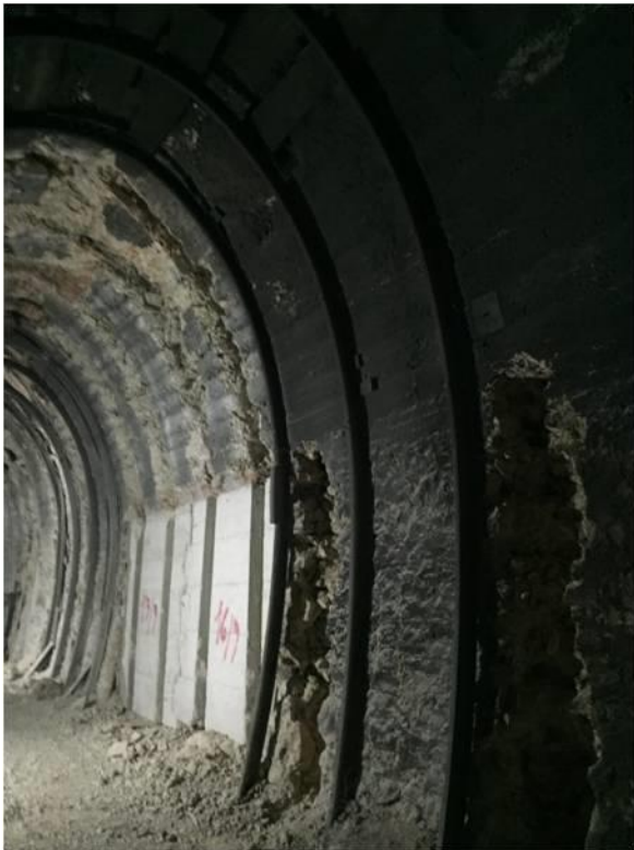
Figura 8 Fasi della lavorazione - inserimento centine
